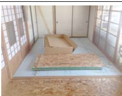
スタイロフォーム(断熱材)を床全面に施工
