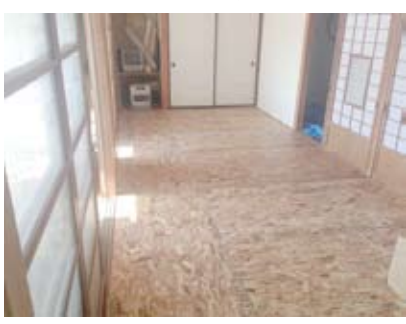
OSB合板を下地材として施工
